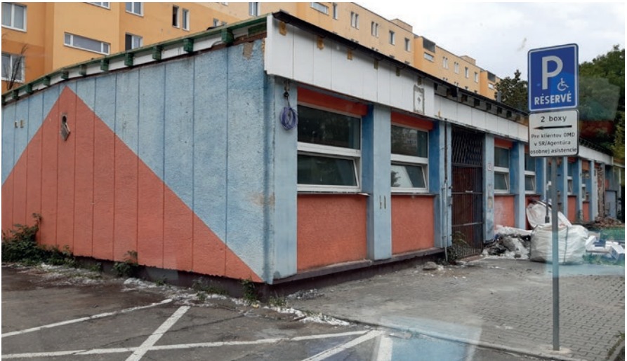
• Budova nového sídla, pohľad zvonku. (Autor: Z archívu OMD v SR)
